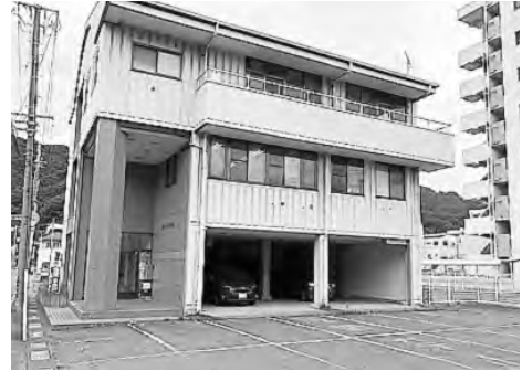
解体前の釜石教育会館外観
